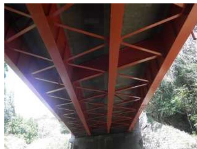
橋梁補修(塗装塗替)
