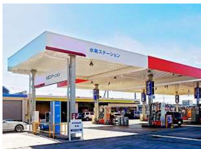
水素ステーション
