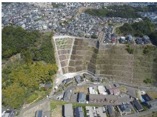
急傾斜地崩壊防止施設
