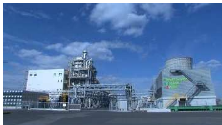
七ツ島バイオマス発電所
