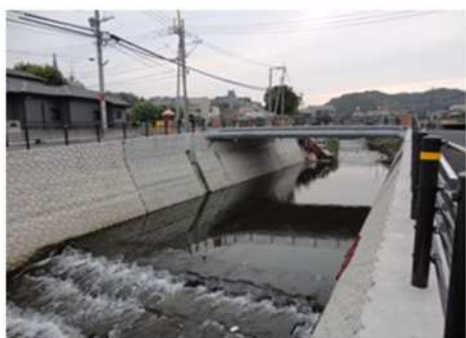
河川改修事業(新川)
