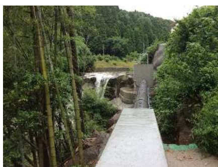
永吉川水力発電所
