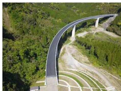
国道504号(西光寺拡幅)
