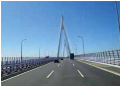
こうしゅうわん 杭州湾海上大橋 2008年5月1日に開通した、全長35,673m、6車線の高速道路で、杭州湾を南北に縦断する海上橋です。
