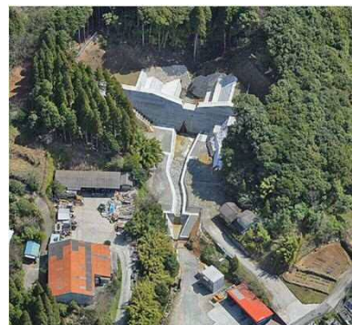
栗山追川(いちき串木野市)砂防堰堤
