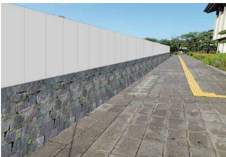
石垣と漆喰壁をイメージした仮囲い (H30.6月～)
