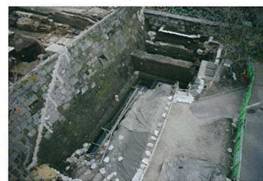
⑨H014面 地下から現れた堀石垣
