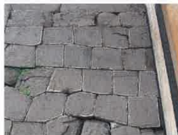
②H013 面 金場取り残し積み・目地漆喰
