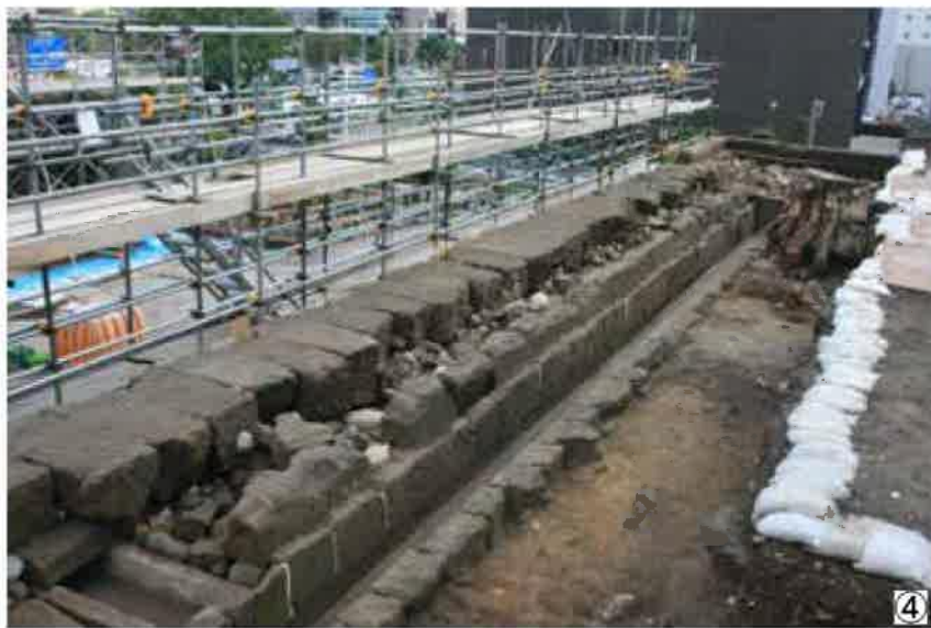
第14図 御楼門櫓形周辺石垣の背面構造（H013面） （出典：鹿児島県立埋蔵文化財センター2020）
