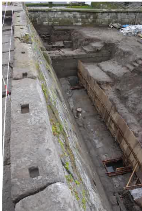
第21図 堀（H014 面全面） （出典：鹿児島県立埋蔵文化財センター2022a）
