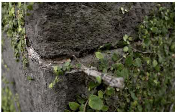
成長して木化したオオイタビのツル が石垣の目地に入り込んでいる
