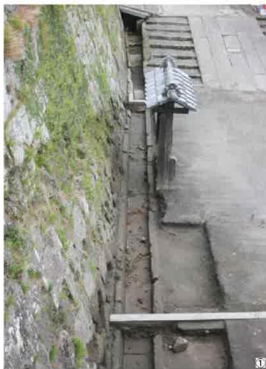
第19図 石組み排水溝（H012 前面） （出典：鹿児島県立埋蔵文化財センター2020）
