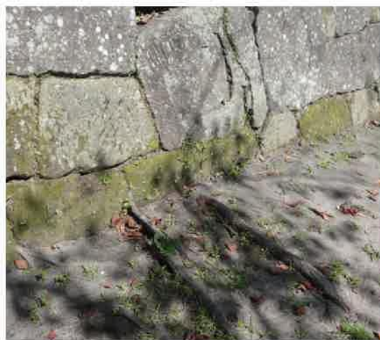
H014 面の目地に入ったサクラの根
