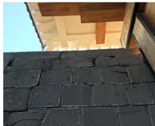
被熱による石材の剥落
