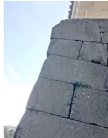
石材の破断
