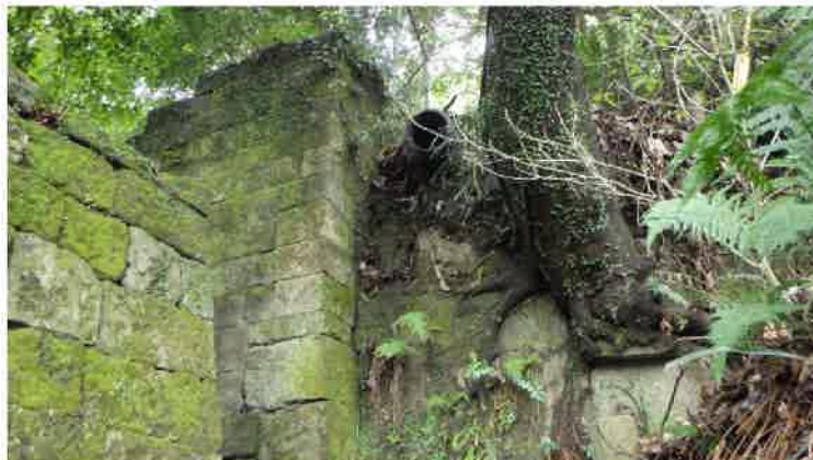
石垣上部に設置されたパイプ
