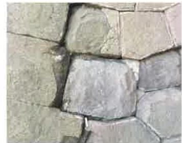
石材の修復箇所
