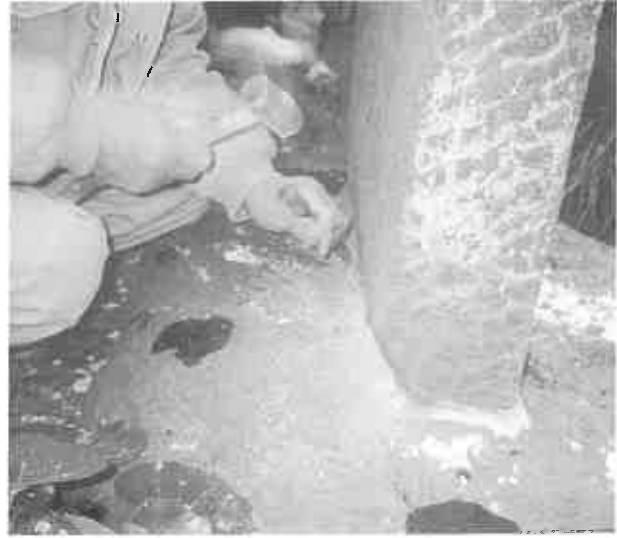
台座との接合部を職人が手作業で削っていく
