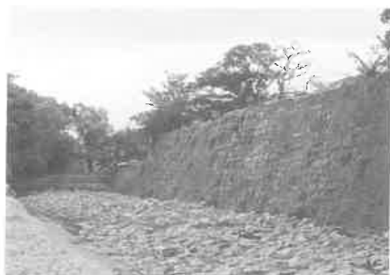
積替工事対象石垣と濠
