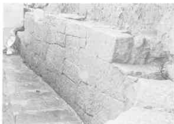
C地点(M-4区)暗渠排水施設完掘状況(北より)
