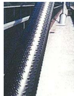
多々羅大橋のケーブルの制震装置
