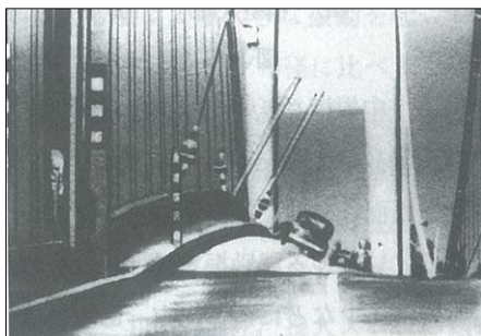
写真 4-3 Tacoma 橋 (道路面)
