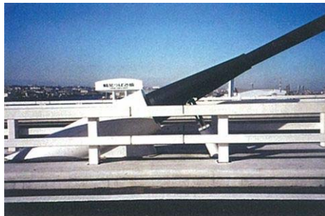
鶴見つばさ橋のケーブル制震装置
