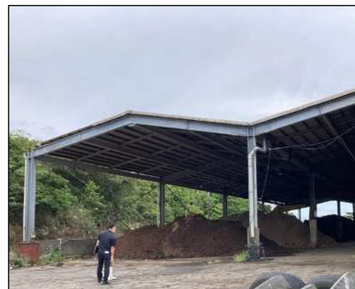
堆肥センターにおける原料集積
