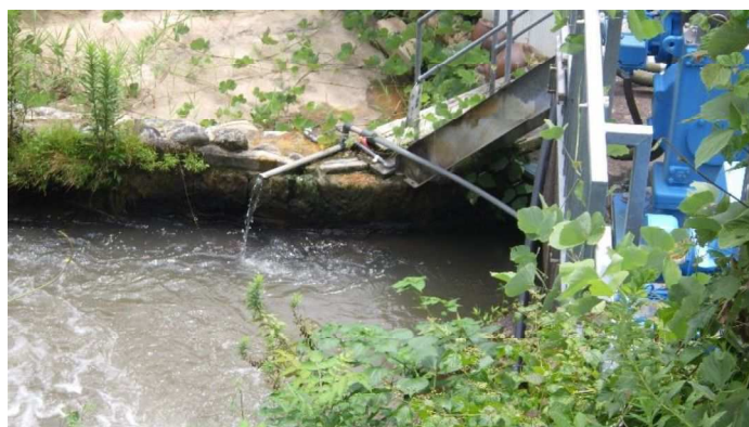
図 1-5 河川への放流状況
