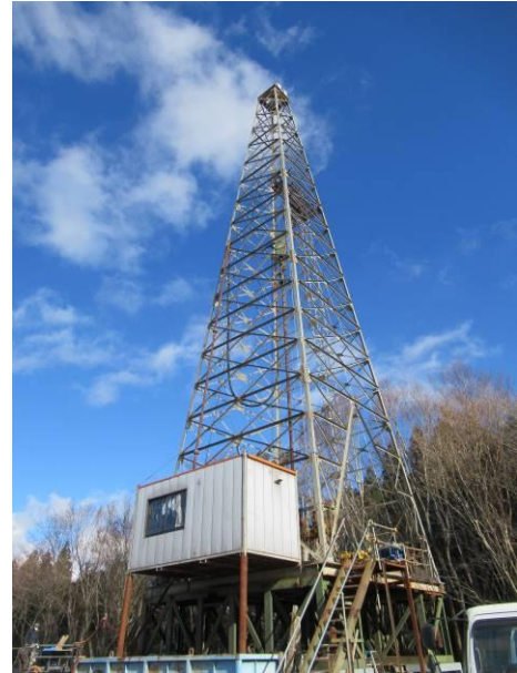
2号生産井掘削現場
