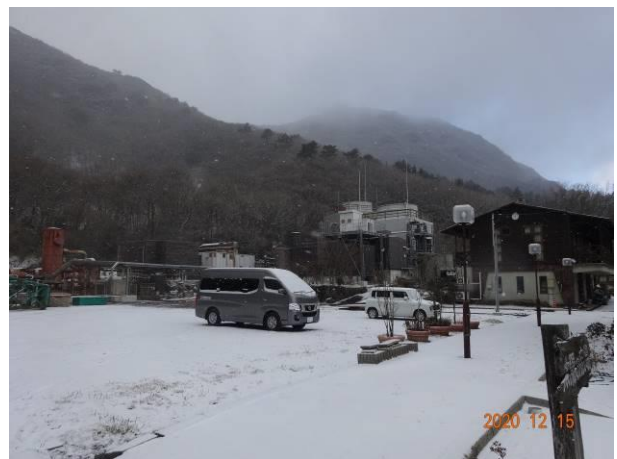
九重地熱発電所
