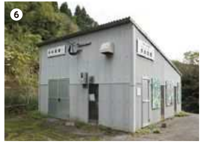
● 永吉川水力発電所 事業者：ひおき地域エネルギー 種類：水力発電
