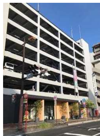
写真 6-14 1階部分を工夫した駐車場の例
