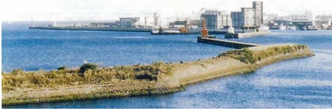
写真 2-4 昭和 57 年頃の防波堤（新波止, 遮断防波堤, 一丁台場）と赤灯台（旧北防波堤灯台） （出典：鹿児島港近代化百年のあゆみ）
