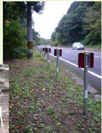
野生動物の交通事故防止用反射板
