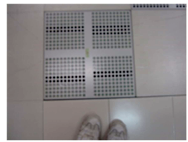
可動式の床の設置 (通信設備室の空調用)
