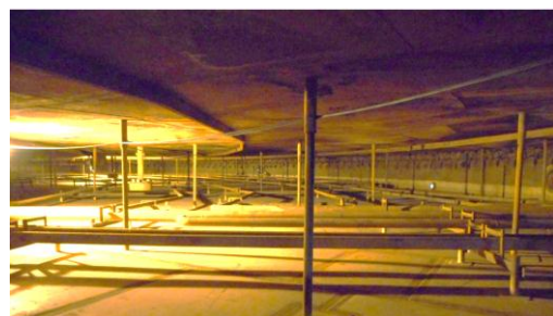
タンク管理温度の適正化 (写真：南方原油タンク内スチーム配管)
