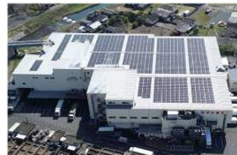
【③太陽光パネル】
