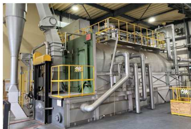
【木質バイオマスボイラー（煙管ボイラー）】
