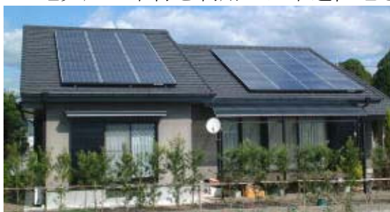
(太陽光発電の設置)
