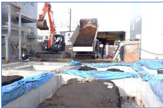
建築物基礎工事の 埋戻材として利用
