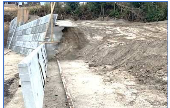
構築物築造工事の裏込材として利用
