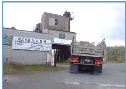
アスファルト塊の処理
