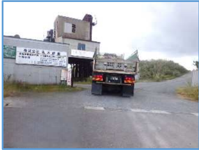
コンクリート塊の処理
