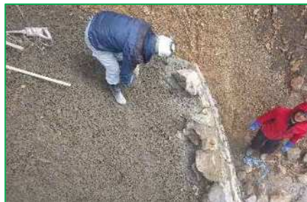
ブロック等の裏込材
