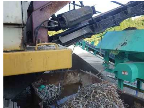
磁選機による金属類除去状況 ・破碎後に磁選機で金属の除去
