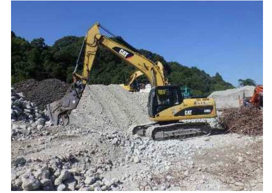
④圧砕機による前処理状況 ・圧搾機で小割するとともに鉄筋や異物の除去を行う
