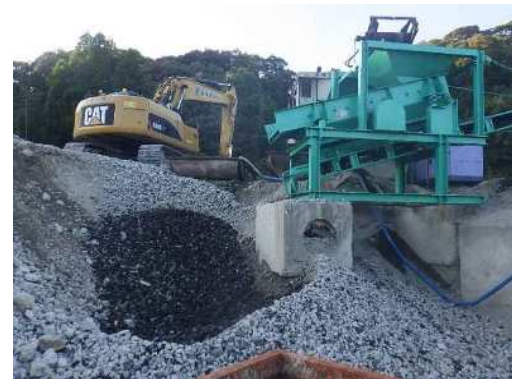
オーバーサイズ ・再度破碎機へ投入して破碎
