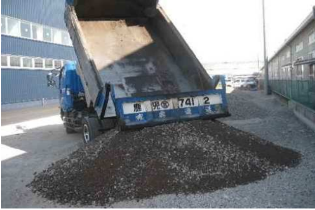
路盤材・基礎材現場搬入
