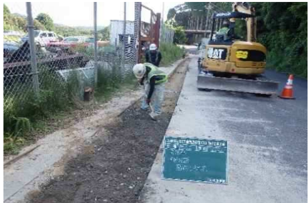
現場施工(路盤材敷均し状況)
