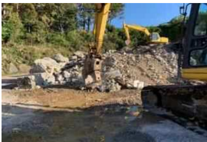
④小割・異物選別 ・大物材について小割 ・磁選機付きの重機で鉄筋等の異物除去
