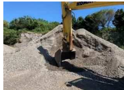
⑭ 再生材と新材の混合 ・ストックヤードにある新材RC-30とRC-30(Co50%,As30%)をバックホウで1対4の割合で計量 ・バックホウで混合して製品とする
