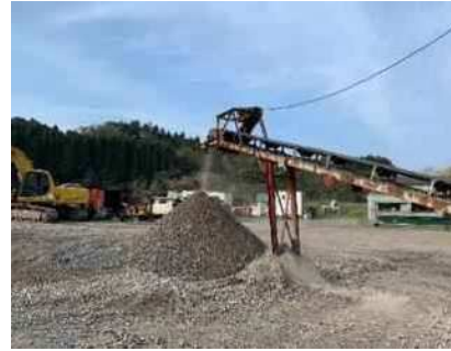
⑬ 破碎された殻は第4ベルトコンベアーで、製品置場へ
