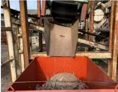
⑩ 磁選機で金属類の除去 ・破碎後に磁選機で金属等の除去
