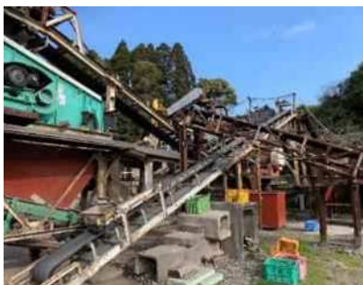
⑫ 第2・3ベルトコンベアー ・オーバーサイズはベルトコンベアーでクラッシャーへリターン ・第2クラッシャーで再度破碎
