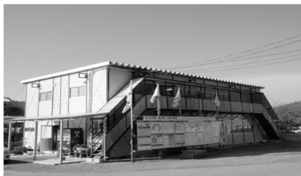
現場事務所設置
