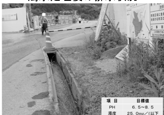
濁水処理後の排水状況
