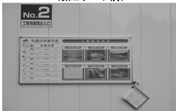
週間作業予定・作業写真 (第2ゲート前)
