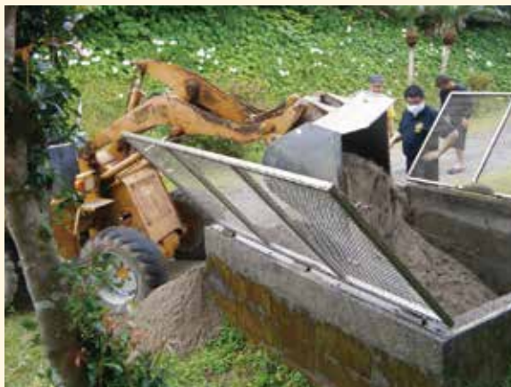
重機による砂の入れ替え(校庭の孵化場)
