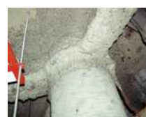
吹付けアスベスト （鉄骨材の耐火被覆）
