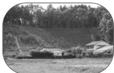
土砂崩れを防ぐ
