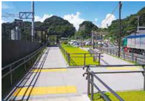
スロープが整備され、だれもが使いやすい駅に。
