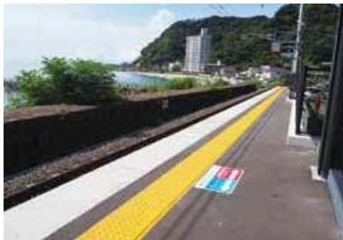
ホームに設置された内方線付き点状ブロック
