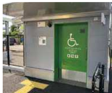
多目的トイレには、さまざまな利用者に配慮した安心の空間が整っている。
