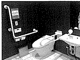
障害者にも利用しやすいトイレ
