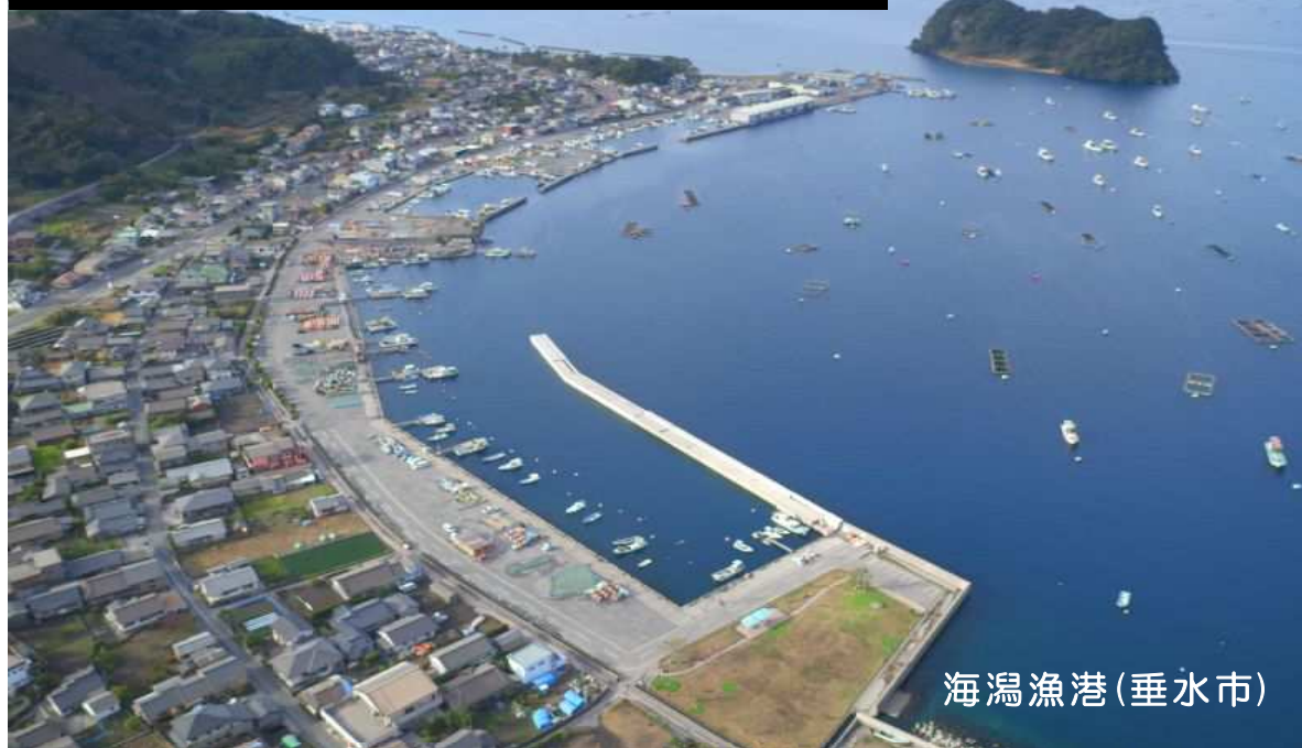
防波堤の整備による安全で使いやすい漁港づくり
