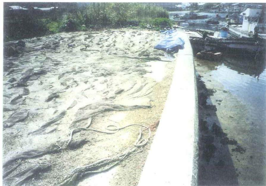
旧河川護岸に係留しているが、前面水深の不足により干潮時に船底がつかえるなど支障がある。
