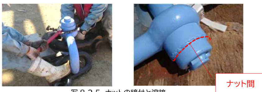
写 8.2.5 ナットの締付と溶接
