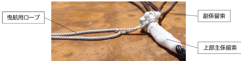
写 8.2.8 曳航用ロープの取付(C点)
