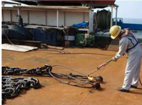
写 8.7.3 固定点(B 点)の溶断
