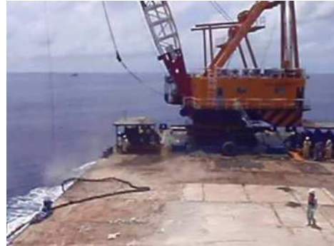
写 8.7.4 アンカー・アンカーチェーンの投入
