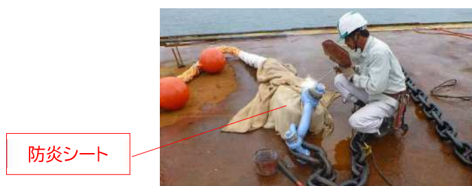
写 8.2.7 係留索付近の溶接
