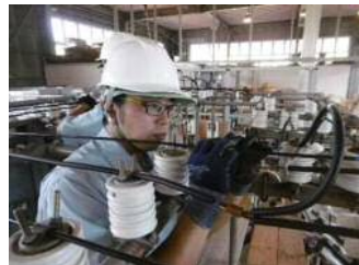
受変電設備工事実習
