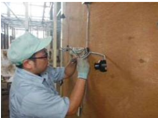
電気工事実習
