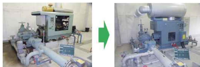
〈老朽化したポンプの補修〉
