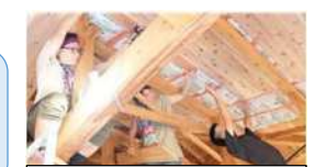
空き家改修ワークショップ
