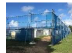
（防風ネットの設置）
