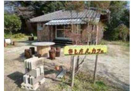
②岸良地区(古民家再生)
