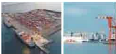
①志布志港湾施設 (志布志市)
