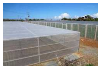
整備が進む鉄骨平張施設
