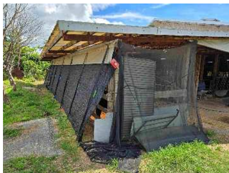
■ 寒冷紗等による高温対策
