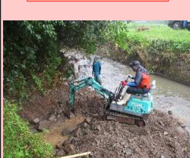
大雨で被災した水路の補修
