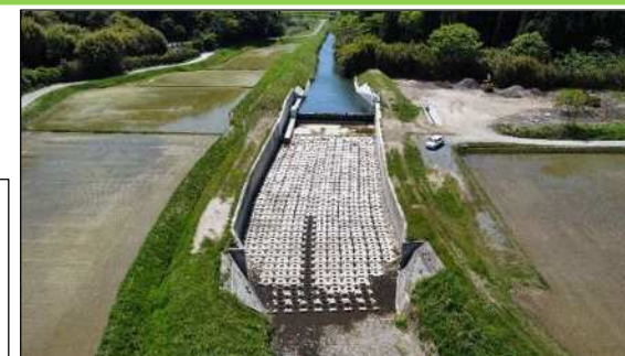
↑【写真5】整備後（下流側から）
