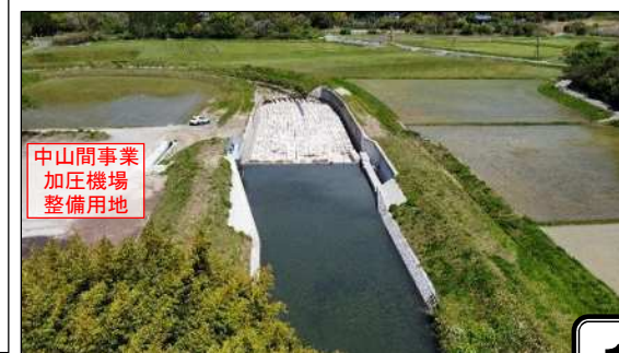
↑【写真6】整備後（上流側から）
