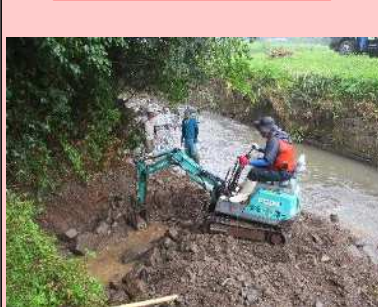
大雨で被災した水路の補修
