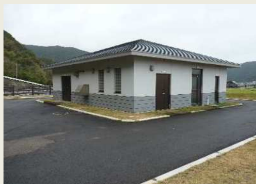
汚水処理施設（大和村 東部地区）
