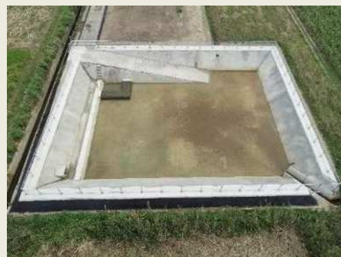
耕土流出防止のための沈砂池
