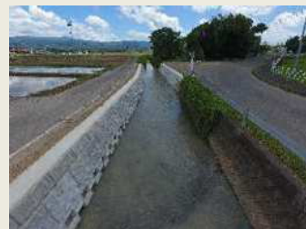
生態系保全水路の整備 (出水西部地区：出水市)
