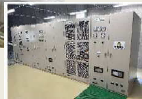
地域用水環境整備事業（高隈地区：鹿屋市）
