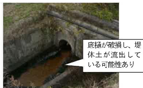
写真 11：底樋出口（堤体下流）
