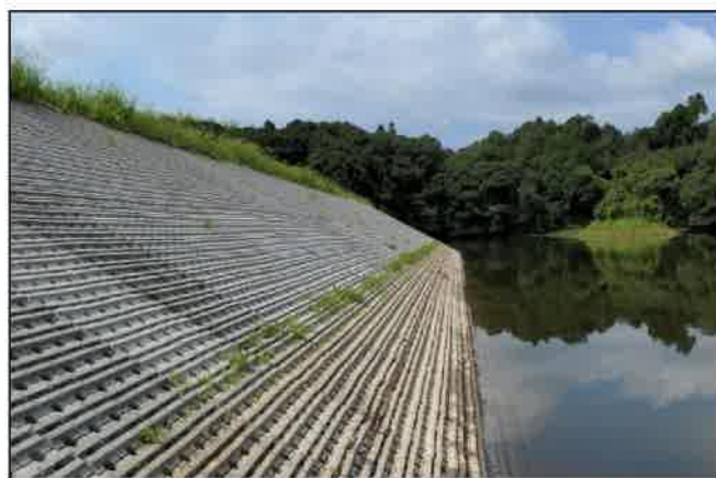
写真5：張ブロック等（中郷下池）
