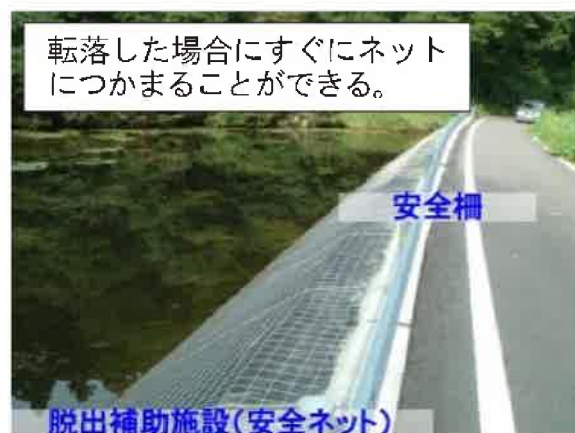
写真 15：安全ネットの設置
