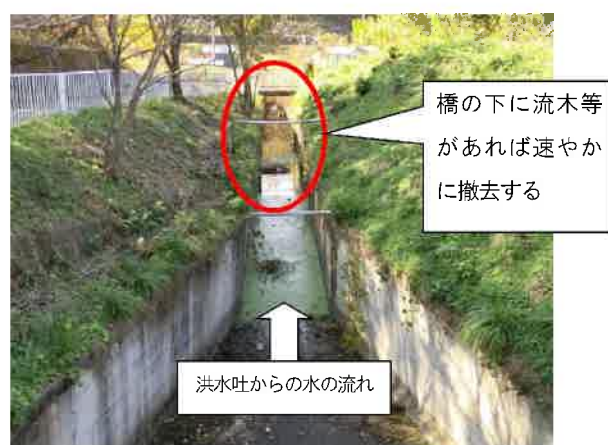
写真8：洪水吐下流水路の例
