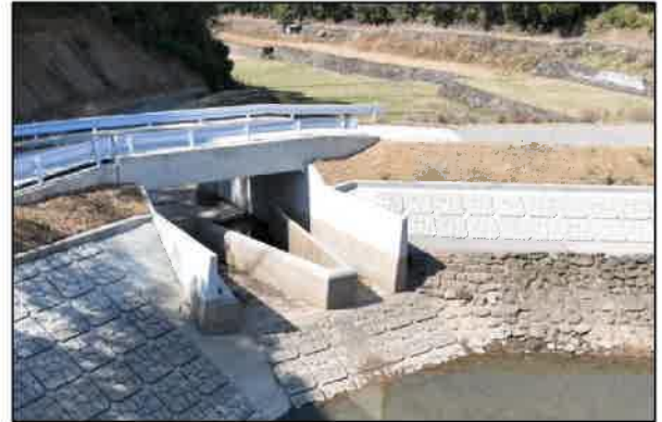
写真2：洪水吐（鹿丸ため池）
