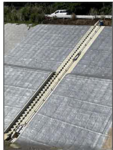
写真3：取水部（斜樋）（大山池）
