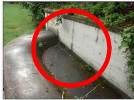
写真9：洪水吐流入部
