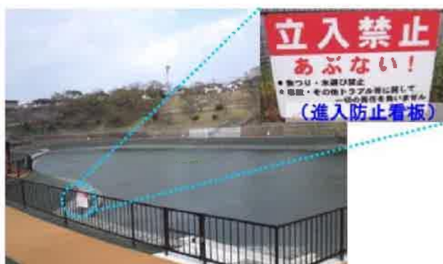
写真 14：安全柵の設置
