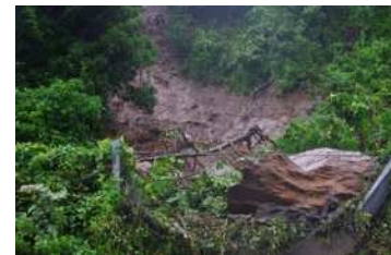
▲平成22年6月豪雨では，斜面崩壊が発生。
