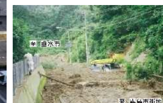
国道への土砂流入状況 (国道220号_霧島市)
