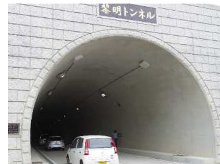
▲トンネル整備による防災機能向上
