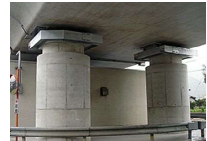
【橋脚の巻立て】
