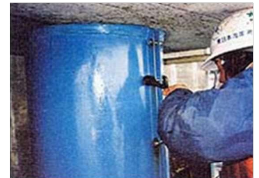
腐食した鋼材を防食材で表面被覆し延命化
