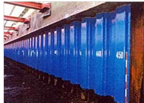
腐食した鋼材を防食材で表面被覆し延命化
