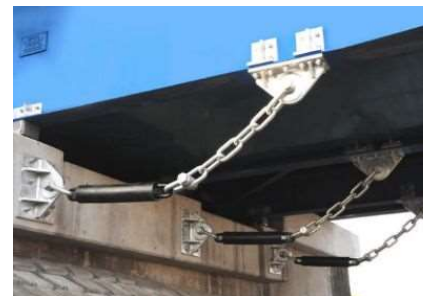
【落橋防止構造】
